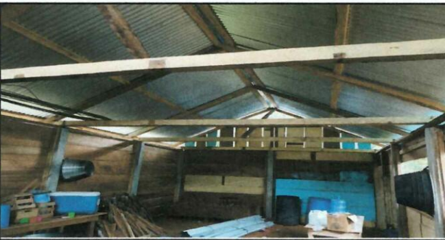
Foto 5: Sustitucion de bigas por Costaneras.
