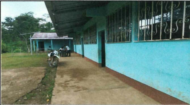
Foto 3: ampliacion de corredor del establecimiento.
