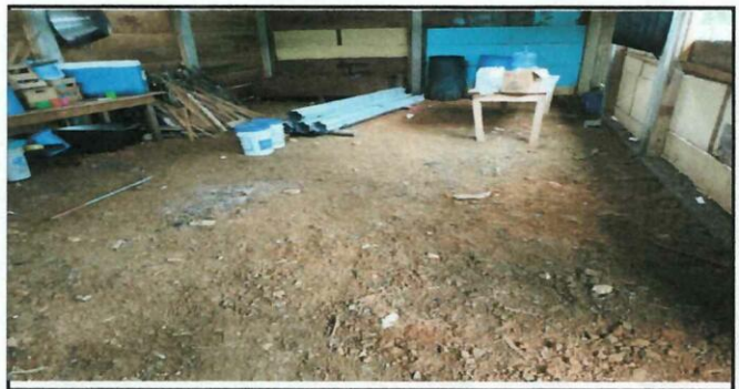
Foto 6: Instalacion de piso, salon de reuniones.
