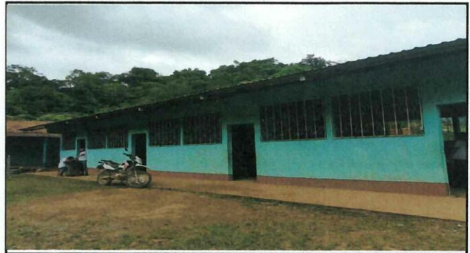
Foto 4: Ssustitucion de vidrios y aplicación de pintura para pared.
